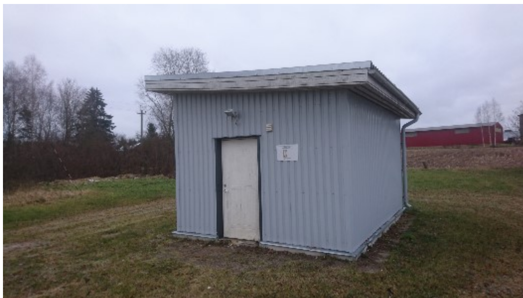
Joonis 14. Saverna puurkaevpumpla välisvaade (2023)
