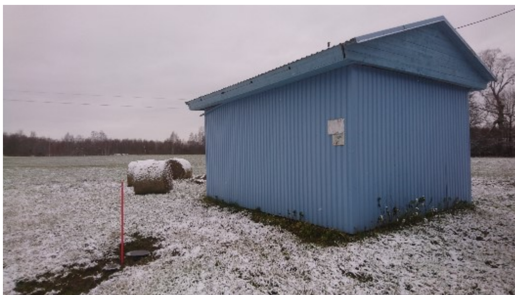
Joonis 36. Ihamaru küla puurkaevpumpla hoone välisvaade (2023)
