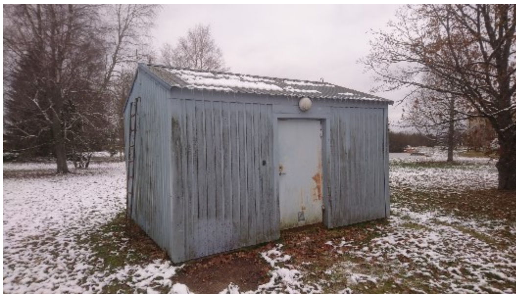
Joonis 21. Valgjärve küla puurkaevpumpla hoone välisvaade (2023)
