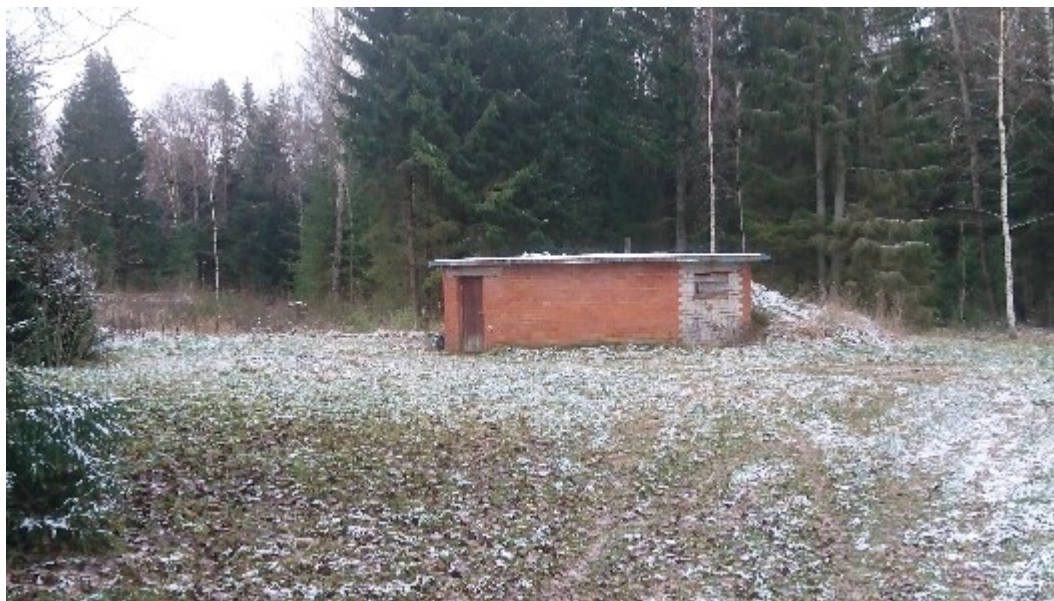
Joonis 30. Soodoma küla puurkaevpumpla hoone välisvaade 1 (2023)
