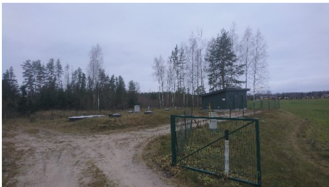
Joonis 16. Saverna reoveepuhasti piirdeaia (2023)
