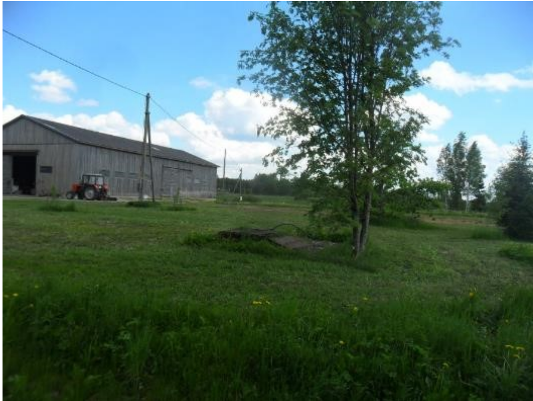
Joonis 47. Kaagvere küla puurkaevpumpla välisvaade (allikas: eelmine ÜVK arendamise kava)
