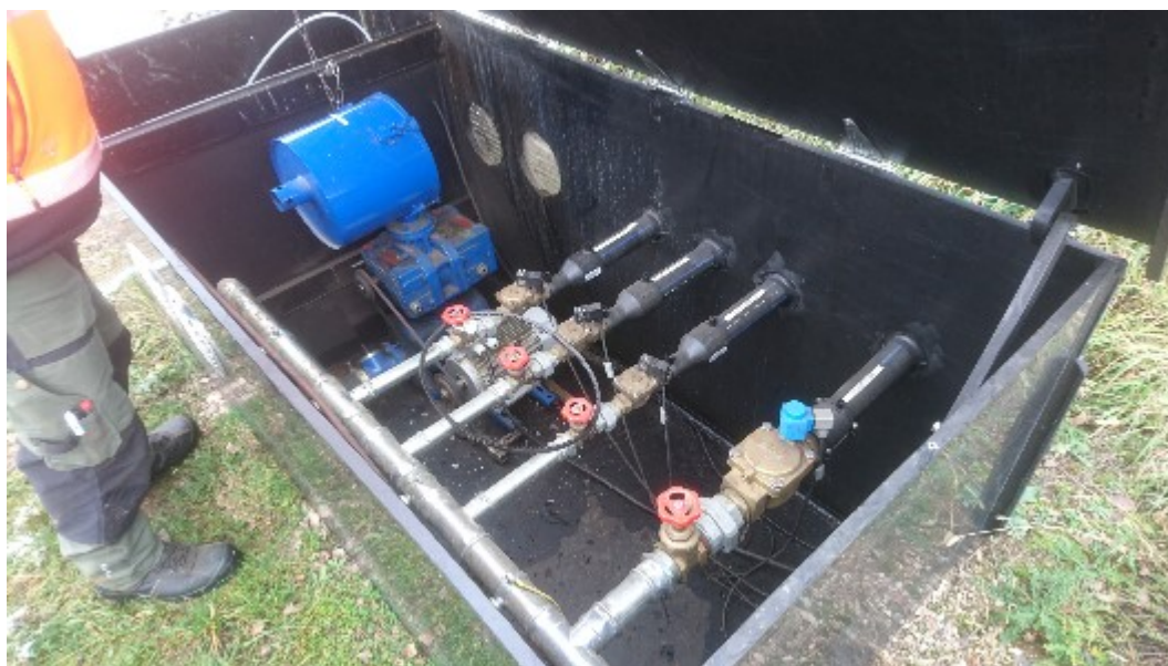
Joonis 12. Puhurid ja keemilise fosforiärastuse kemikaali dosaator (2023)
