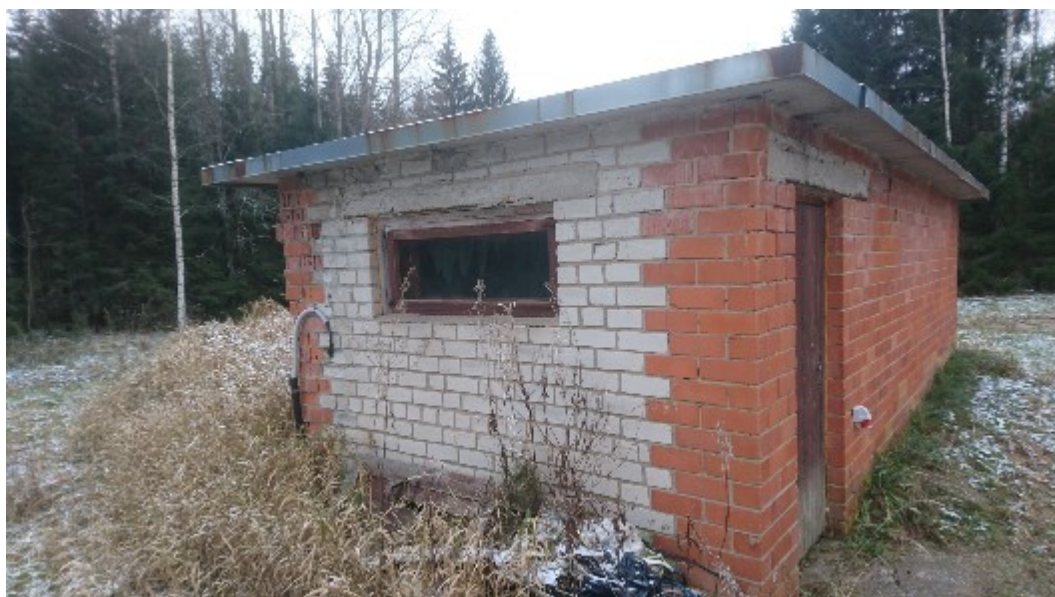
Joonis 31. Soodoma küla puurkaevpumpla hoone välisvaade 2 (2023)
