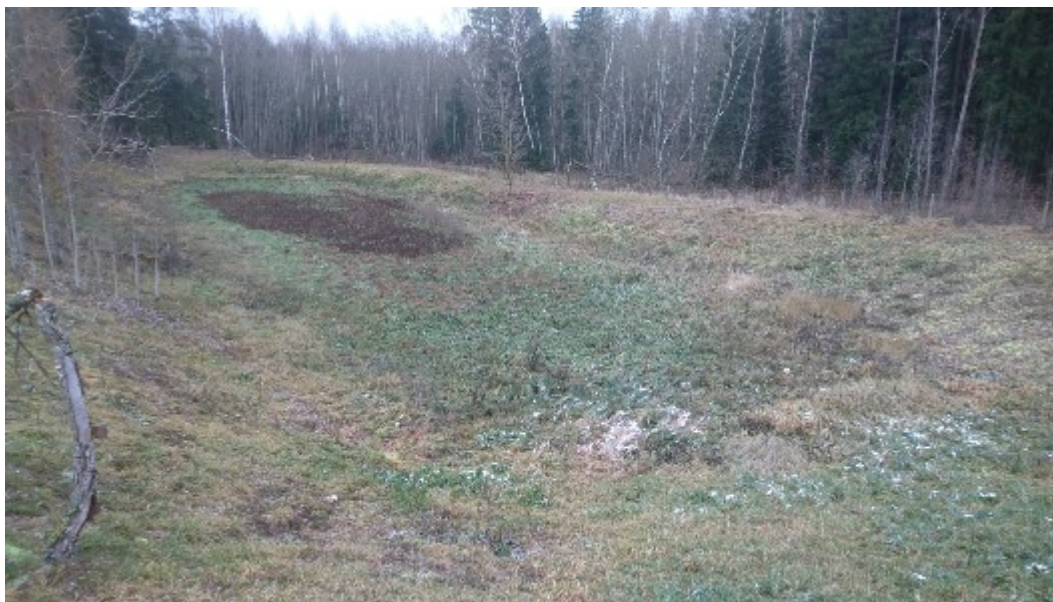
Joonis 17. Saverna reoveepuhasti kinnikasvanud biotiik (2023)
