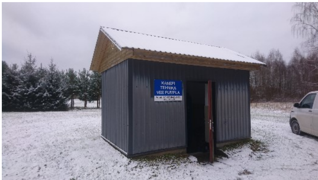
Joonis 4. Kanepi Tehnika puurkaevpumpla välisvaade (2023)
