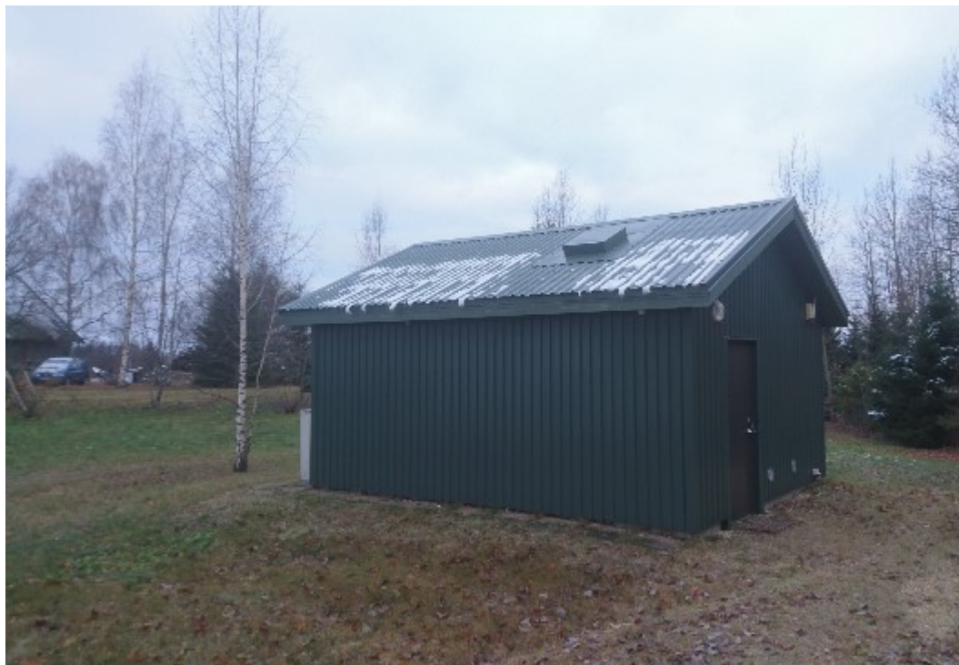
Joonis 26. Maaritsa küla puurkaevpumppla hoone välisvaade (2023)
