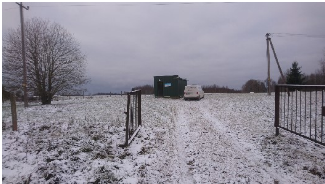
Joonis 34. Hurmi küla puurkaevpumpla hoone välisvaade (2023)
