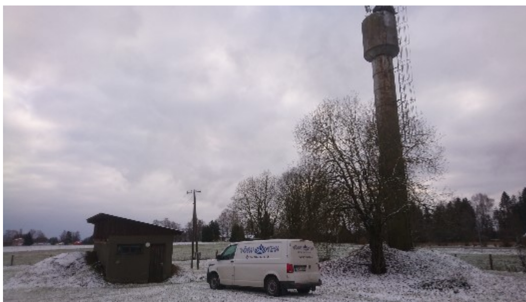
Joonis 9. Põlgaste küla puurkaevupumpla hoone välisvaade ja veetorn (2023)
