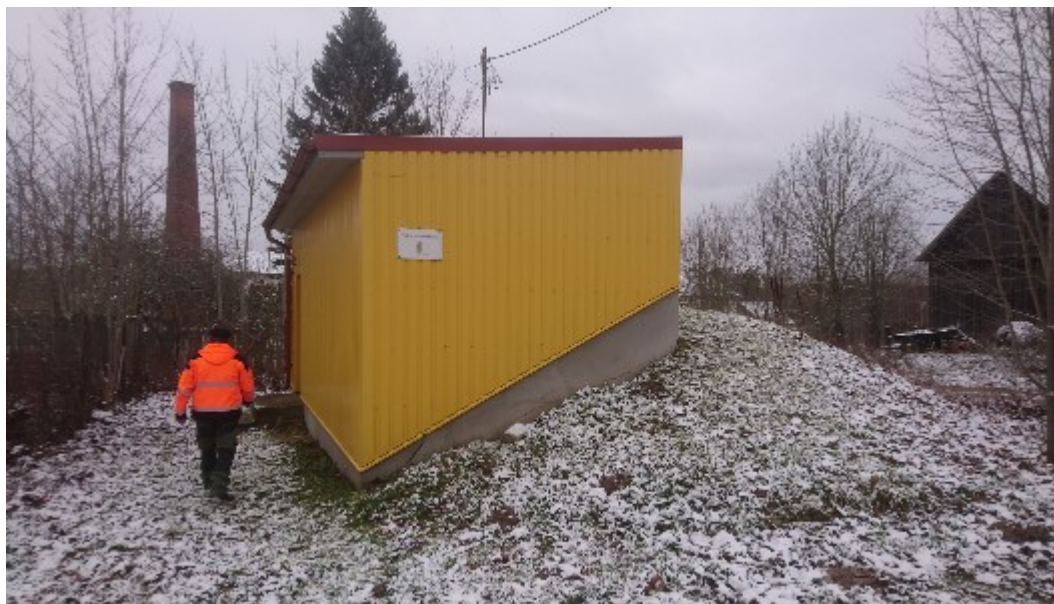
Joonis 41. Erastvere küla puurkaevpumpla hoone välisvaade (2023)
